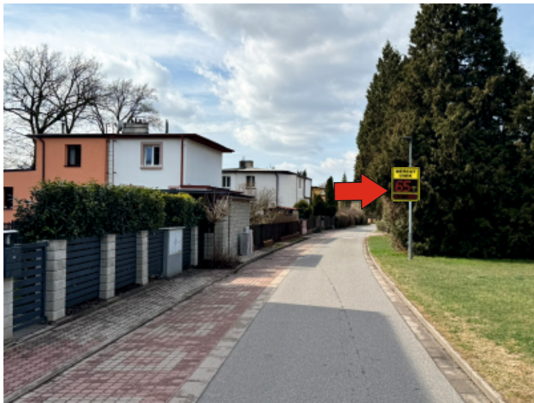
Pohled na ukazatel rychlosti ze směru od silnice II. třídy Umístění na stávající sloup VO naproti Veverkova č.p. 9
